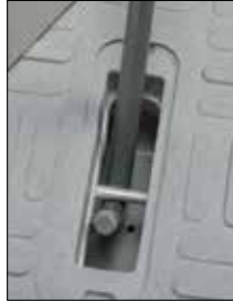
Pasador de elevación empotrado con cubierta
