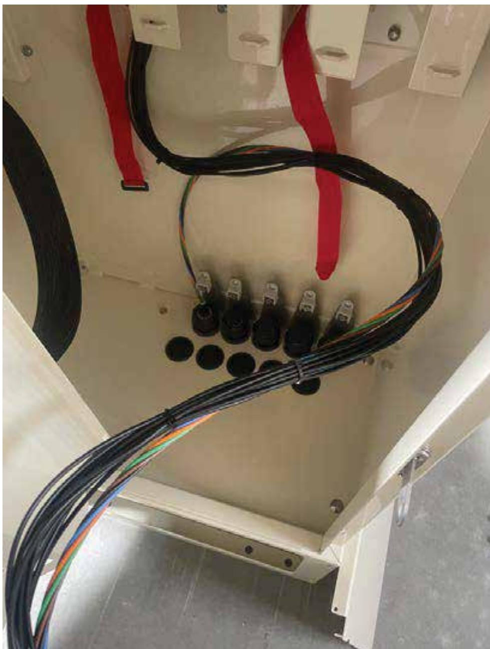
3. Dirija los tubos de protección dentro de la canasta floja más cercana al puerto de entrada usando el grandes anillos de guiado de cables.
