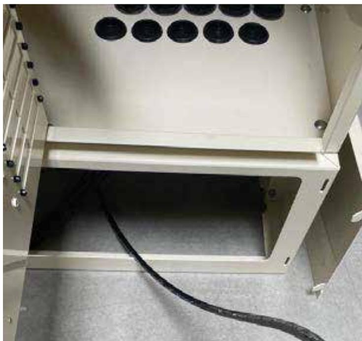
7. Pase el cable a través del puerto de entrada de cables.
