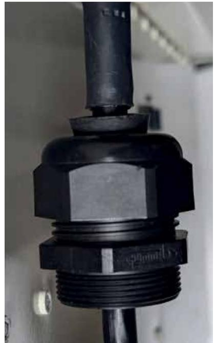
7. Asegure el prensacables al gabinete apretando la tuerca inferior a la parte roscada del conjunto del prensacables.
