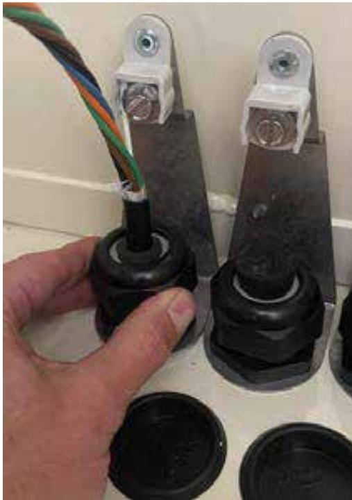
13. Deslice la tuerca inferior hacia arriba del cable preparado y apriétela para asegurar el sello del cable al cuerpo del gabinete.
