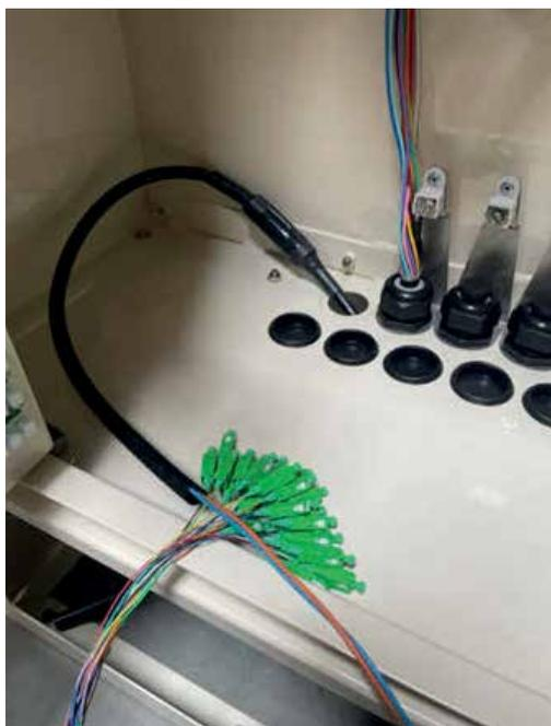
5. Pase los conectores y el cable a través de las 2 piezas del prensaestopas y luego deslícelos más allá de la bifurcación hasta el puerto de entrada de cables.
