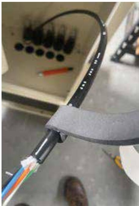
10. Deslice el resto del conjunto del sello del cable sobre el extremo del cable preparado.
