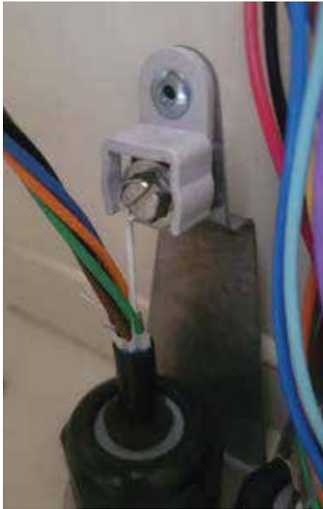
12. Alinee la parte superior del conjunto del sello del cable con el puerto de entrada del cable, asegurándose de que la rosca se encuentra dentro del puerto.
