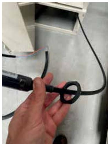
4. Conectores de alimentación y cable a través del puerto de entrada de cable.
