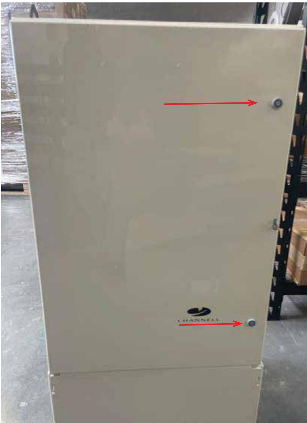
2. Afloje el sujetador del panel oscilante y levante el tope de giro del panel frontal.
